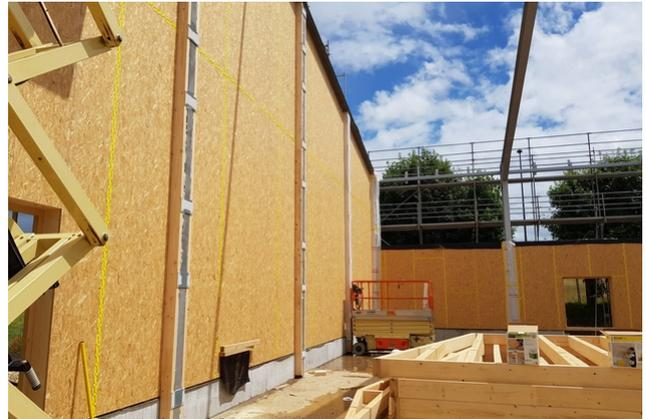
Die alte Metallstruktur wurde verstärkt. Timbatec zeigte sich verantwortlich für die konstruktiven Details und Bemessung des Daches und der Gebäudehülle. Ebenso kontrollierte Timbatec die Wärmebrücken und Oberflächenkondensationsrisiken.
