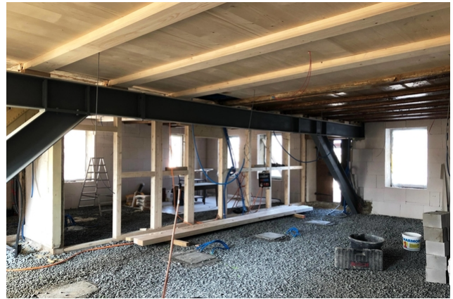
Stahlträger im Altbau
