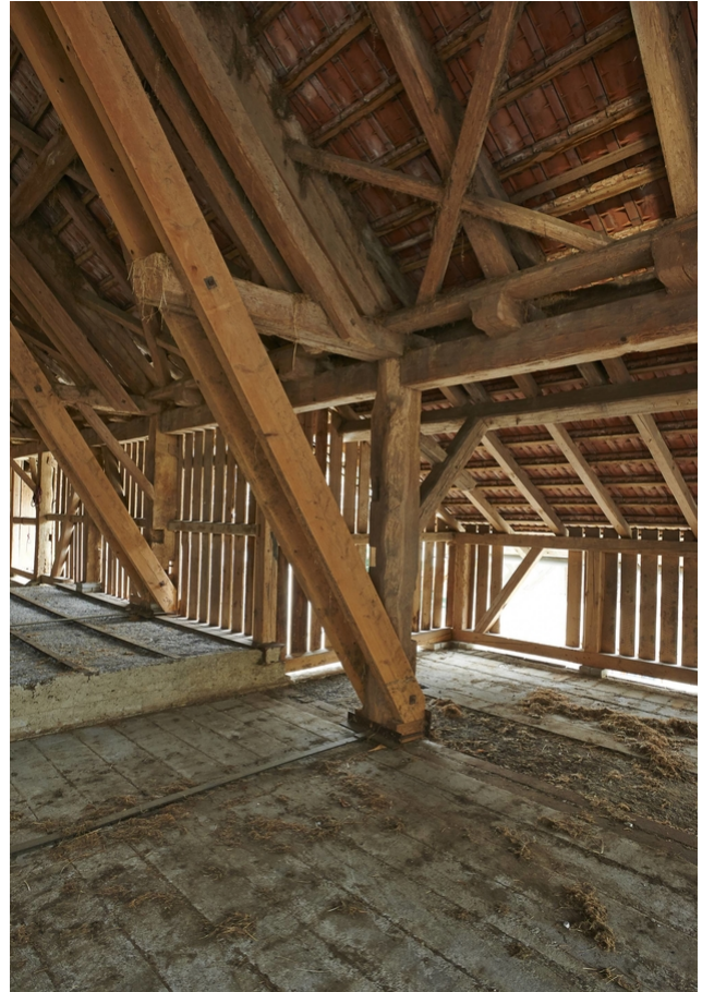
vor dem Umbau
