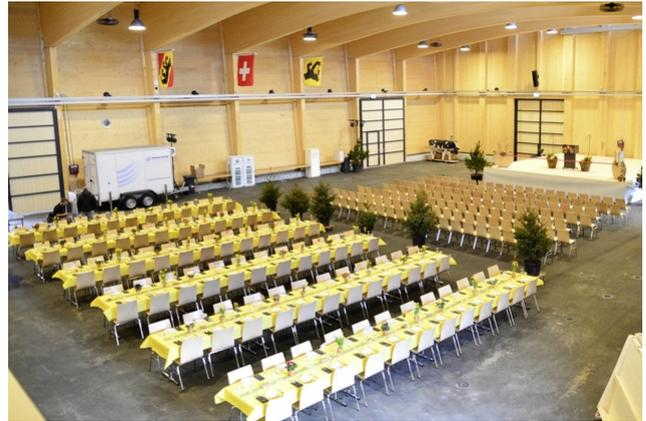
Die Simmental Arena, die neue multifunktionale Halle in Zweisimmen, besteht zum grössten Teil aus Schweizer Holz. Und: Sie kommt ganz ohne Stützen im Innern aus. Das Dach wird von zehn 38 Meter langen Bogenbindern getragen.
