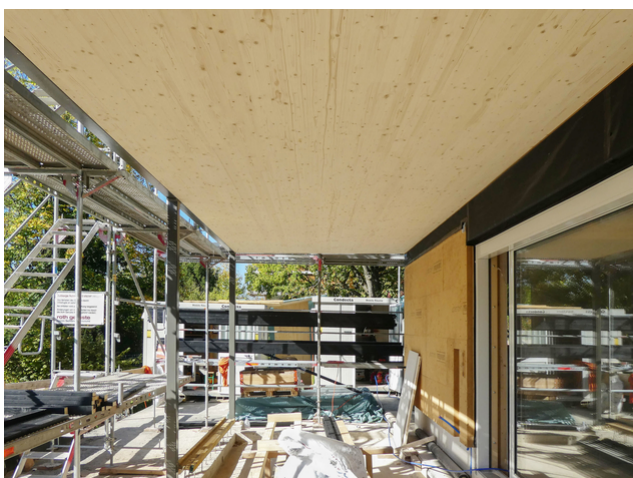
Eine der Holzterrassen während den Bauarbeiten
