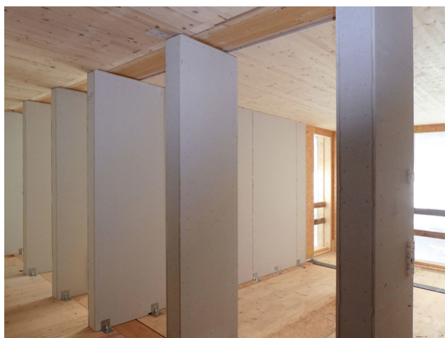
Blick ins Innere: Im Vordergrund sind die Stützen zu sehen, welche die Decke tragen
