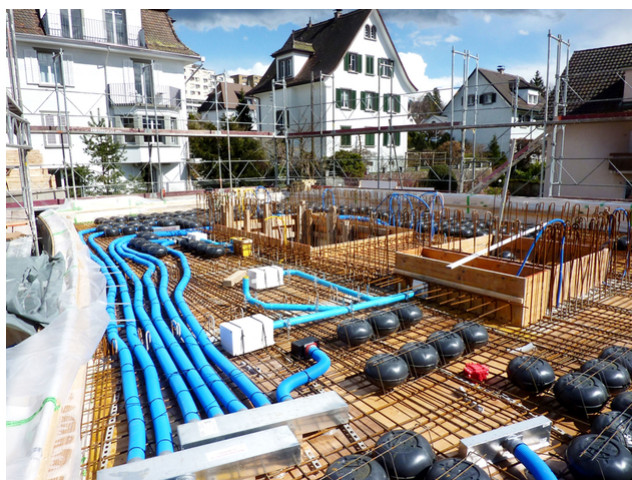
Betondecke über EG kurz vor dem betonieren
