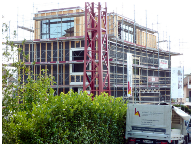
Aussenansicht strassenbseitig von oben im Rohbau
