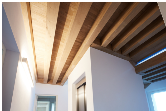
Treppenhaus und Liftschacht in Holzbauweise
