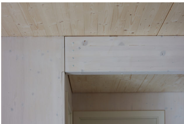
Unterzug mit eingefrästem Stahlblech
