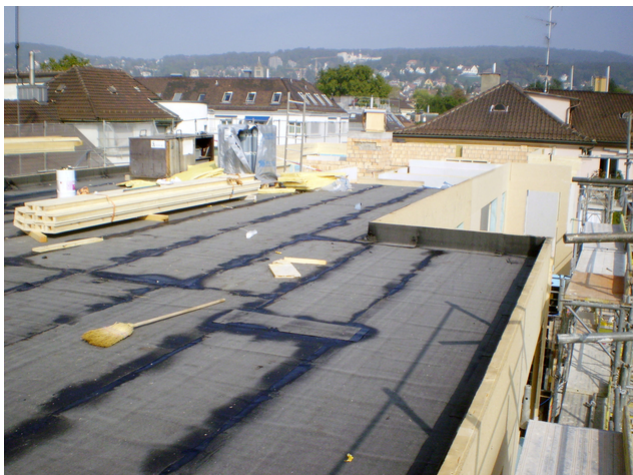
Aufstockung Erker Rohbau
