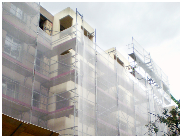
Aufstockung Erker Rohbau 2
