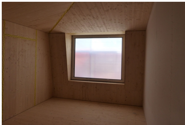
Innenansicht während der Bauphase
