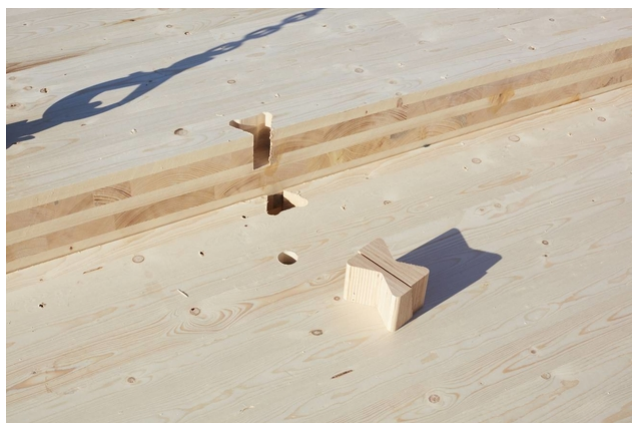
Das Gebäude während der Entstehung
