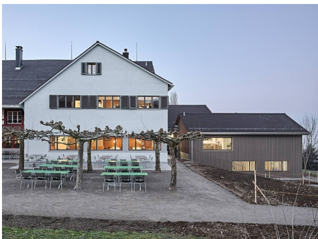
Photo de droite : le nouveau bâtiment en bois conçu par Timbatec
