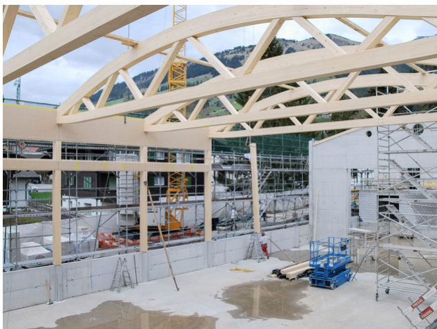
Plus grande hauteur de la structure porteuse grâce à l'aile inférieure légèrement courbée vers le haut des poutres en treillis
