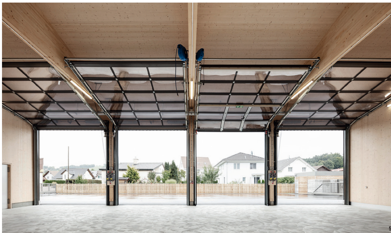
5 Unten Recyclinghartbeton, oben Satteldachträger aus Brettschichtholz. Vom Umschlagplatz erfolgt die Zufahrt in die stützenfreie Einstellhalle durch die vier Tore aus Plexiglas. Dank einer Durchfahrthöhe von 4,2 Metern ist das auch mit grösseren Fahrzeugen möglich.
