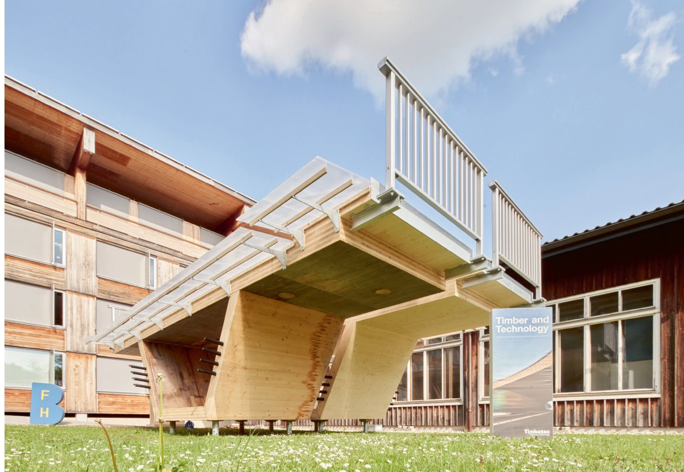
Ziel ist, dass Schwerlastbrücken mit vorgespannten Hohlkastenelementen als grosse Bauwerke wie Autobahnbrücken und Viadukte dienen können.
