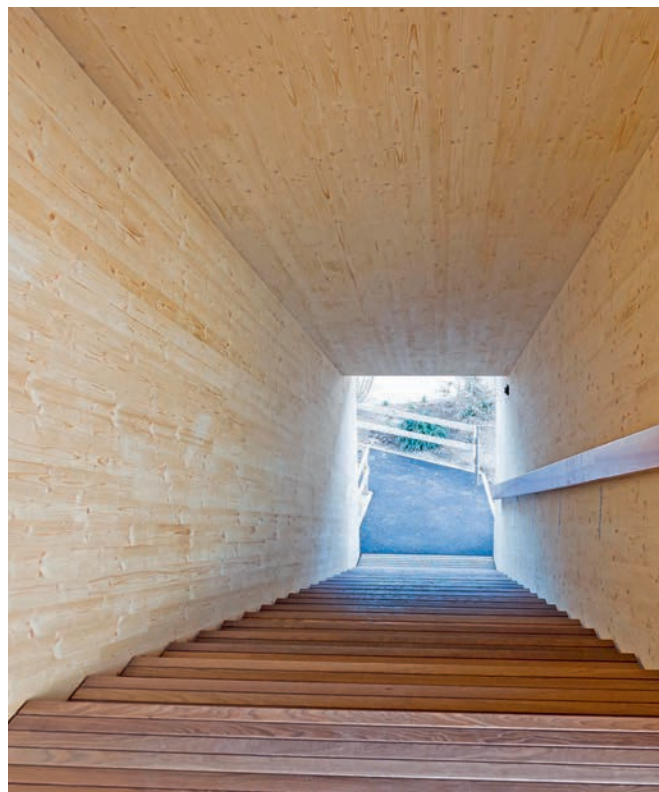
Die Holzkonstruktion ist als vierseitig geschlossene, steife Röhre ausgebildet.
