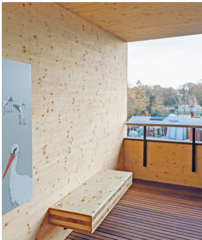
Bis zu 26 Zentimeter dicke Mehrschichtplatten aus Fichtenholz wurden verbaut.
