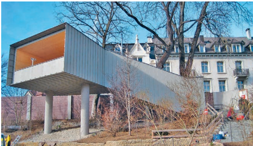
Die hinterlüftete Fassade aus vorvergrauten Mehrschichtplatten ist als Stülp-schalung konzipiert.
