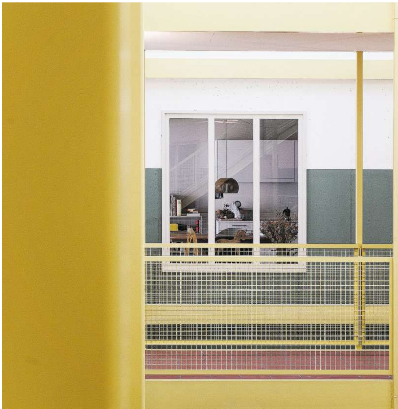
Im einstigen Industriequartier wird jetzt gewohnt: Atrium im Genossenschaftsteil der Winterthurer Lokstadt.
