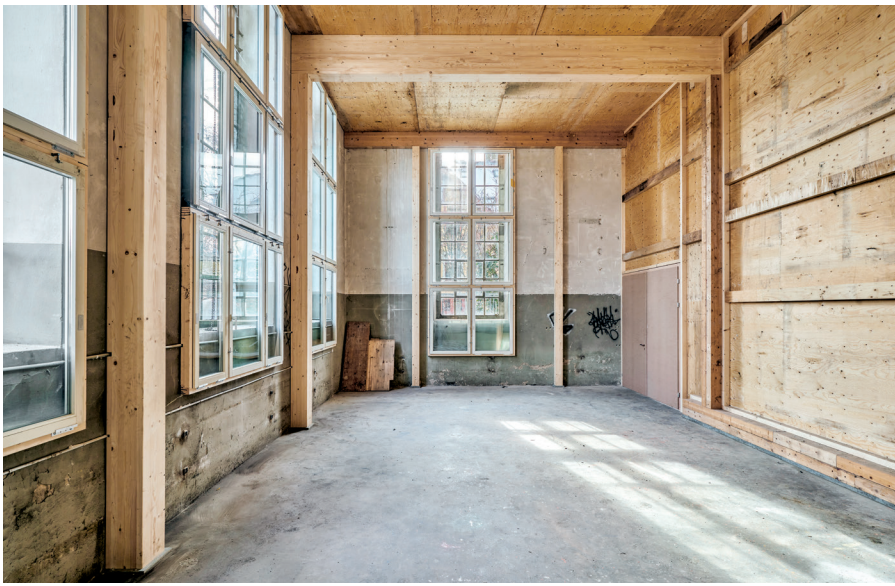
26 Die Künstlerateliers im alten Gaswerk in Schlieren bestehen aus wiederverwendeten Bauteilen.
