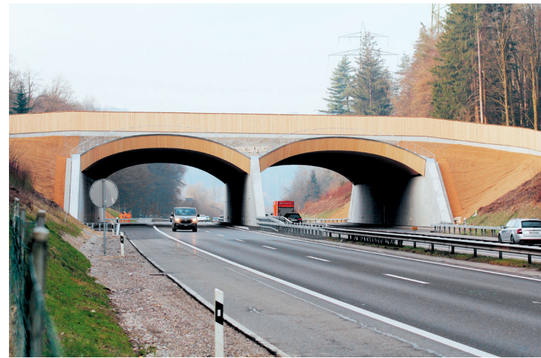
25 Mit der Wildtierüberführung bei Suhr stösst der Holzbau in neue Sphären vor. Foto: Astra
