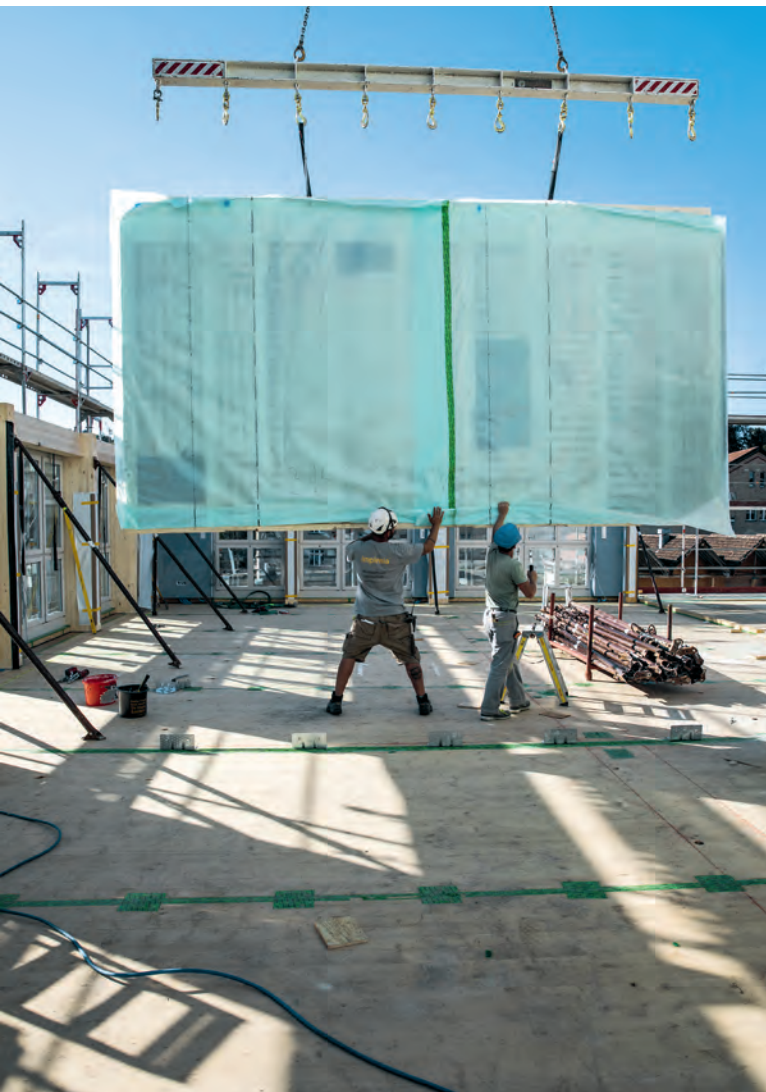
Die Holzkonstruktion wird als Element auf die Baustelle geliefert. | La construction en bois est livrée sur le chantier en tant qu'élément.
