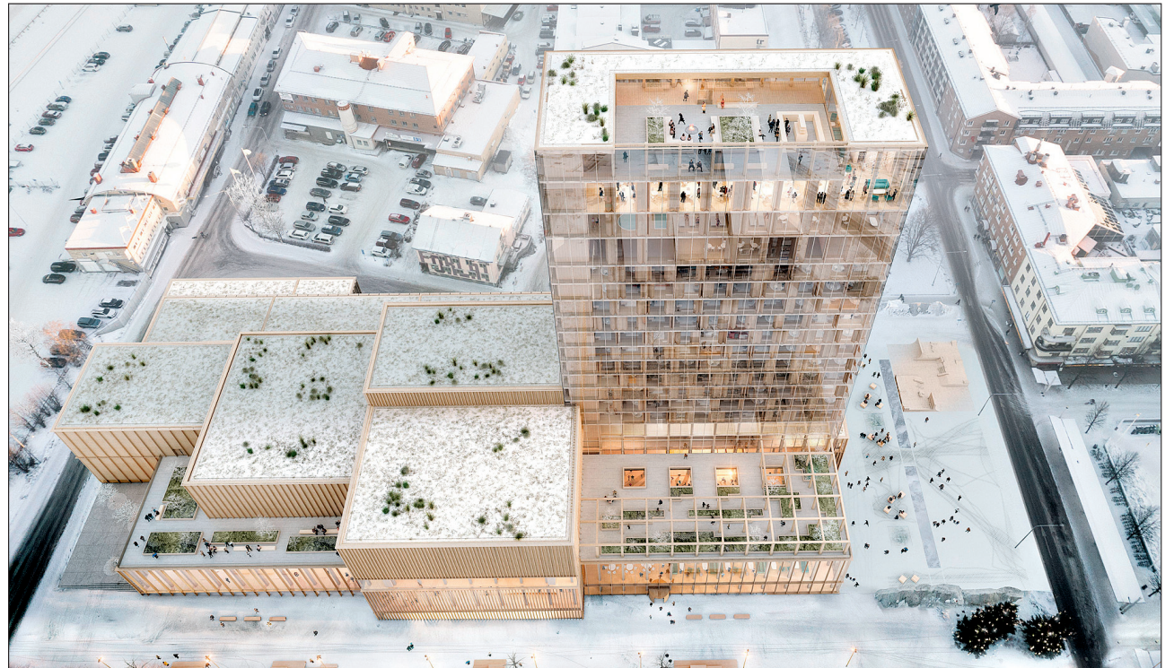
Das Kulturzentrum Skellefteå aus der Vogelperspektive, in der die unterschiedlichen Volumes für Probebühne, Werkstätten, Anlieferung, Eingangsbereiche, zwei Hauptbühnen, Bibliothek, Restaurant und Hotelkomplex gut erkennbar sind.
