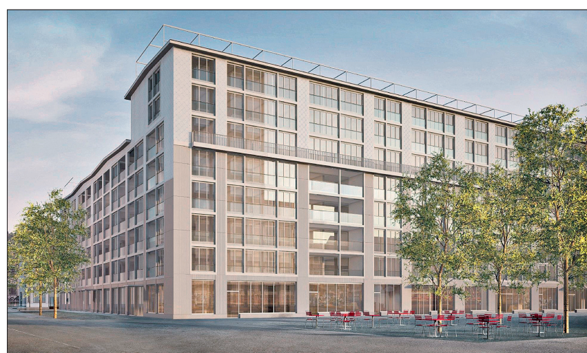
Das Haus „Krokodil“ wird nach Fertigstellung zu den größten Gebäuden seiner Art zählen. Grafik: Implenia
