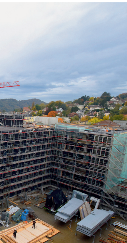
Ein Teil des Krokodils in Winterthur von oben.
