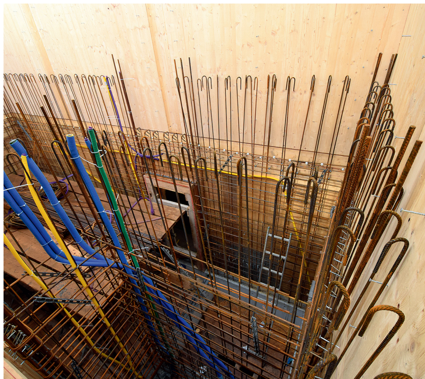
Die verlorene Schalung des Treppenhauses von oben. Betoniert wird erst, wenn der Holzbau steht.
