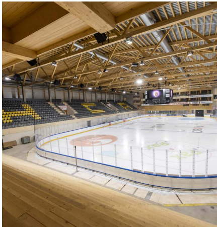
Raffaisen Arena, Porrentruy
