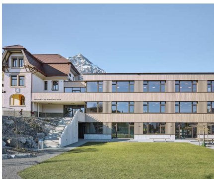
Anbau Primarschulhaus, Aeschi
